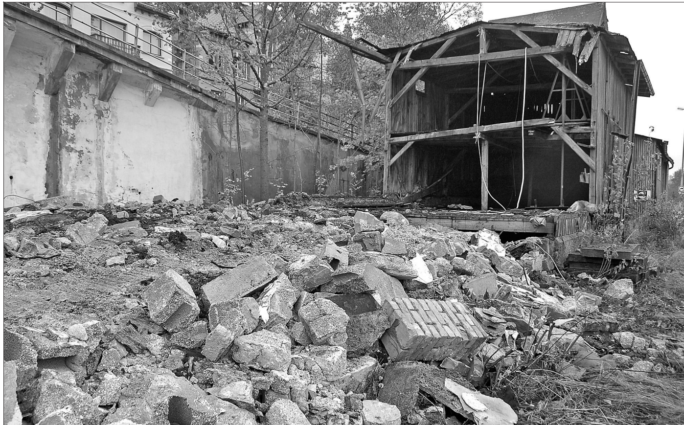
Das Ende des ersten Schuppens am Tailfinger Bahnhof – die anderen sollen laut WEG jedoch stehen bleiben. Fotos: Hertle
