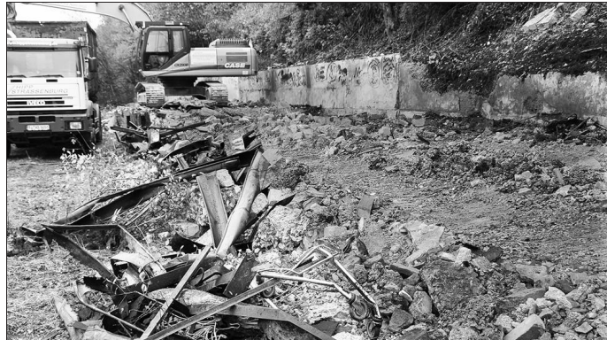
Dem Unrat am Tailfinger Bahnhof rücken die Bagger zu Leibe.
